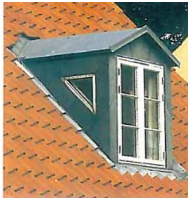
Ny tagkvist med zinkdækkede sider (flunke) og tag. Bemærk flunkernes beskedne tykkelse, der svarer til forholdene på den ældre tagkvist t.v. Hvis flunketykkelsen øges, kommer kvisten til at se "tykkindet" og klodset ud.
